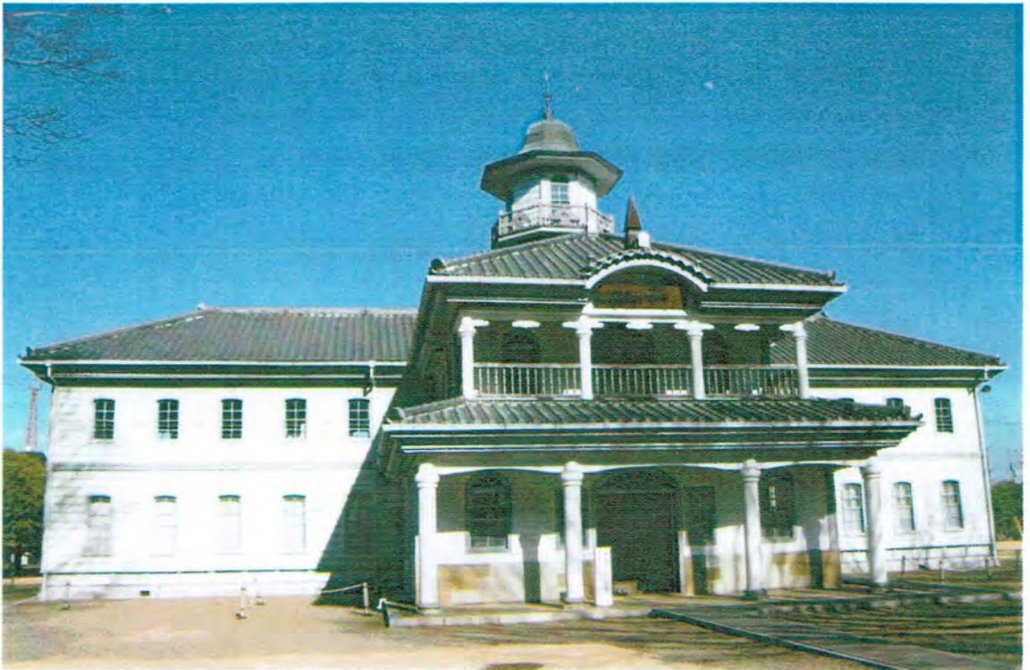
旧水海道小学校本館
